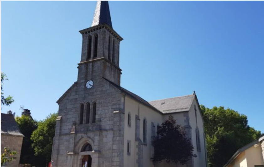
L'église de Saint-Laurent-de-Muret (OTCC Gévaudan Destination)
