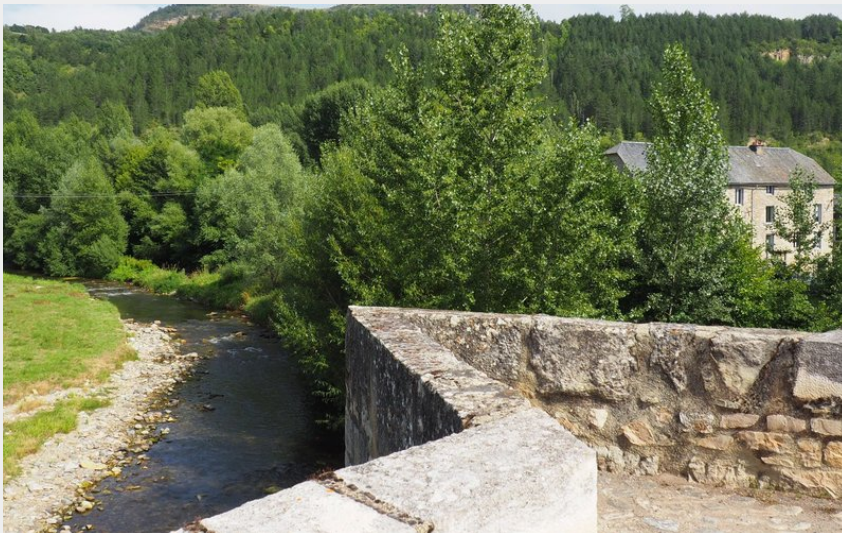
Pont sur la Colagne (© OTCCGD)
