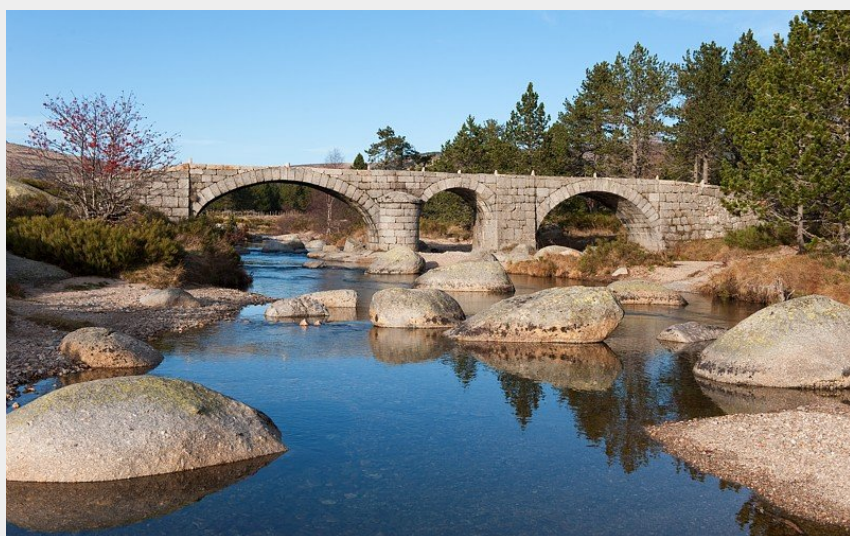
Le pont du Tarn (© Guy Grégoire)
