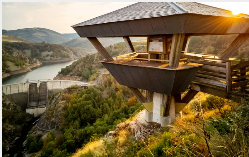
Barrage de Puylaurent (© OT Mont Lozère)
